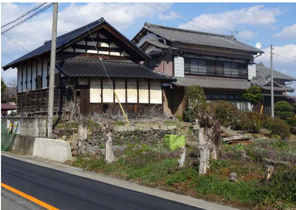
微高地の法面を形成する川原石の石垣 (2017.3)
