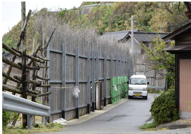
鉄骨や板に支えられた間垣 (2019.5)
