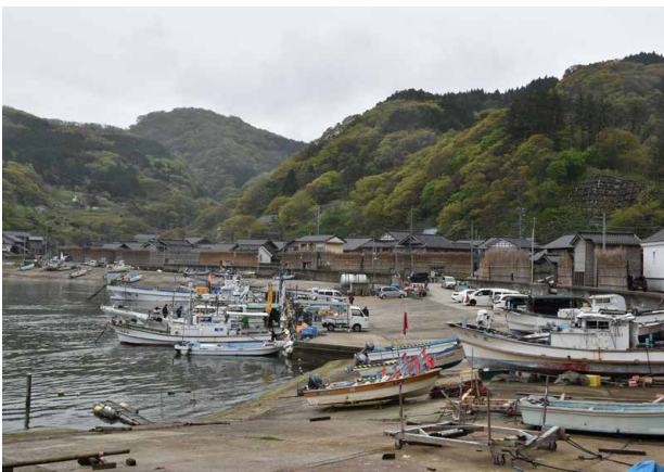
コンクリートコンクリートで拡張された水辺空間 (2019.5)
