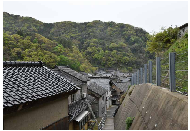
能登沖地震後に葺替えられた黒瓦が卓越する (2019.5)
