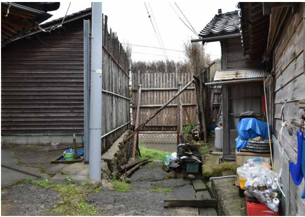
物置場などとして使用される間垣の背後空間 (2019.5)
