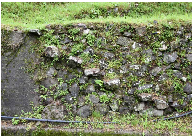
石積みに設けられた昇降用の石段 (2019.6)
