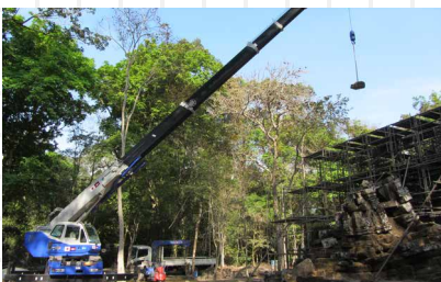
西トップ遺跡南祠堂解体作業中
