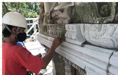
西トップ遺跡中央祠堂装飾石材修復中
