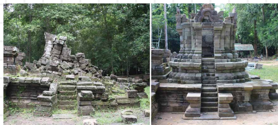
西トップ遺跡北祠堂修復前(左)・後(右)
