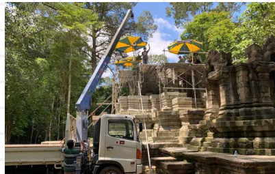
西トップ遺跡中央祠堂再構築作業
