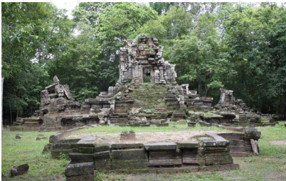
西トップ遺跡修復前写真
