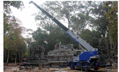
日本製クレーンが威力を発揮する 西トップ遺跡の修復現場
